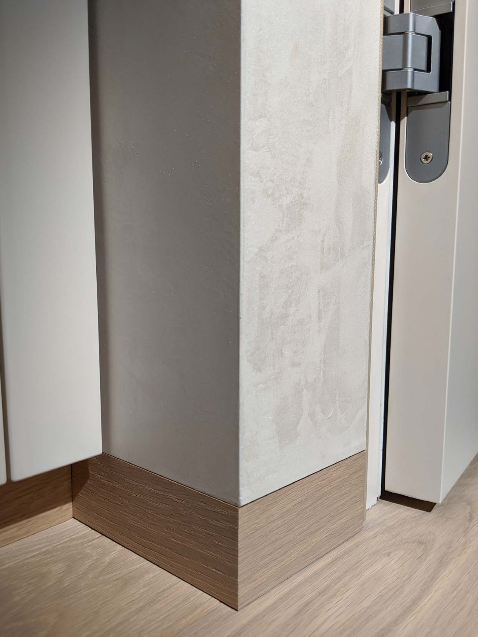
Detail napojení Soclicku na neviditelnou zárubeň Classic 40mm a provedení špalety.
